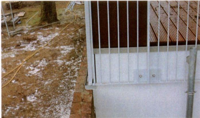
5. Ook de gemetselde tuinmuur werd onderdeel van de nieuwe woningen.
